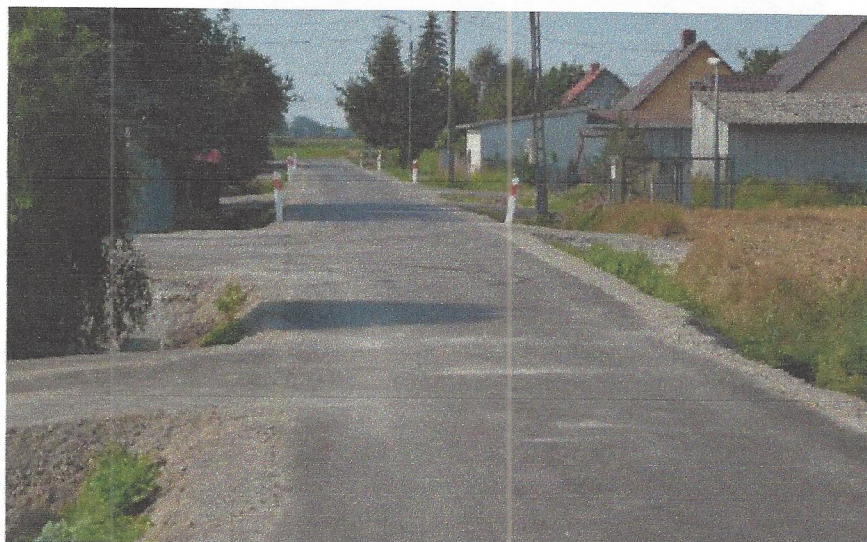
Źródło: zdjęcie z zasobów Urzędu Gminy Kwidzyn przedstawiające zrealizowaną inwestycję – remont drogi gminnej w Pastwie.
