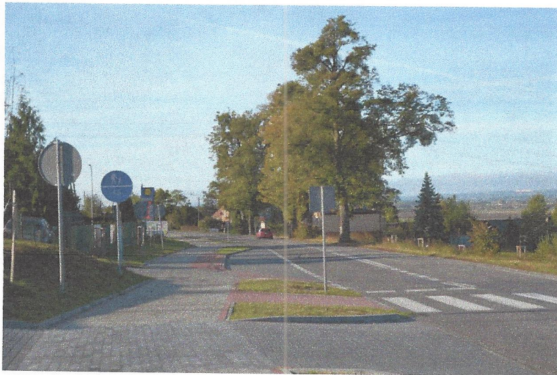
Źródło: zdjęcie z zasobów Urzędu Gminy Kwidzyn przedstawiające inwestycję – budowa ciągu pieszo-rowerowego w Rozpędzinach
