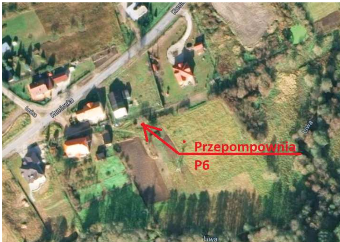
FOTO 3 Orientacyjna lokalizacja przepompowni P6 w terenie
