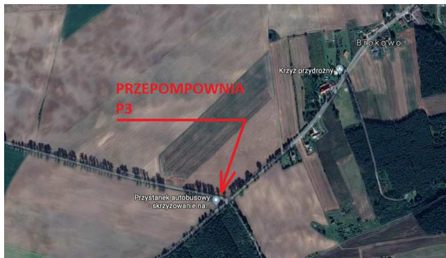
FOTO 1 Orientacyjna lokalizacja przepompowni P3 w terenie
