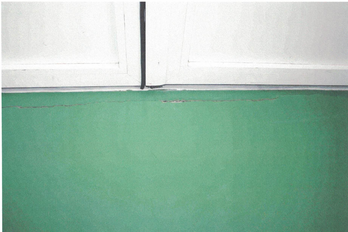
Fot. 5 Wykładzina – pęknięcia
