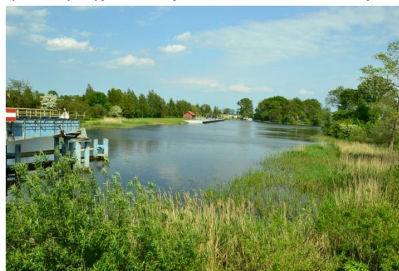
Fot. 9 Szkarpaва, widok na fragment mostu obrotowego oraz nabrzeże w miejscowości Rybina
